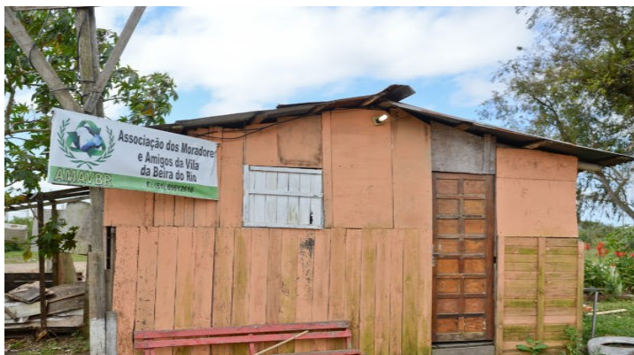
Galpão de reciclagem improvisado construído pela comunidade da Vila Beira do Rio
